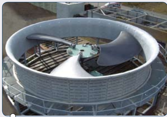
Grote geluidsarme koelventilator (bron: Howden Fans)
