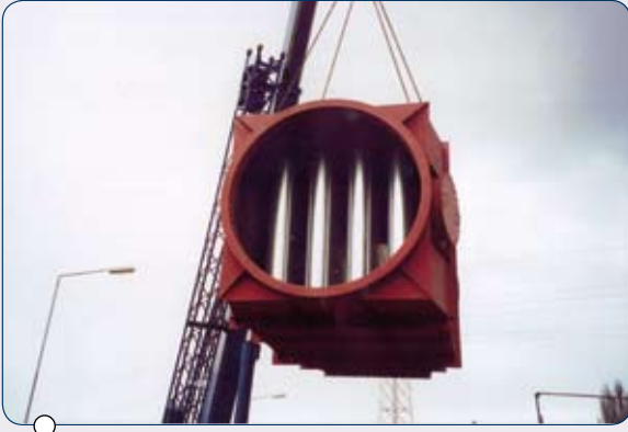
Hittebestendige geluidsdemper voor uitlaat gasturbine (bron: BBM Akustiek technologie)
